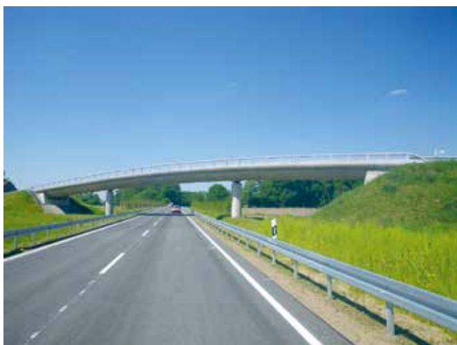
Abbildung 37: Beispiel Mehrfeldbrücke (Quelle: LS NRW)
