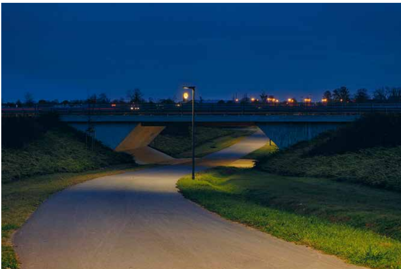
Abbildung 42: Einsehbarkeit Unterfahung K 17 Kerpen-Manheim-neu bei Dunkelheit aus Westen (Bild: Kolpingstadt Kerpen)
