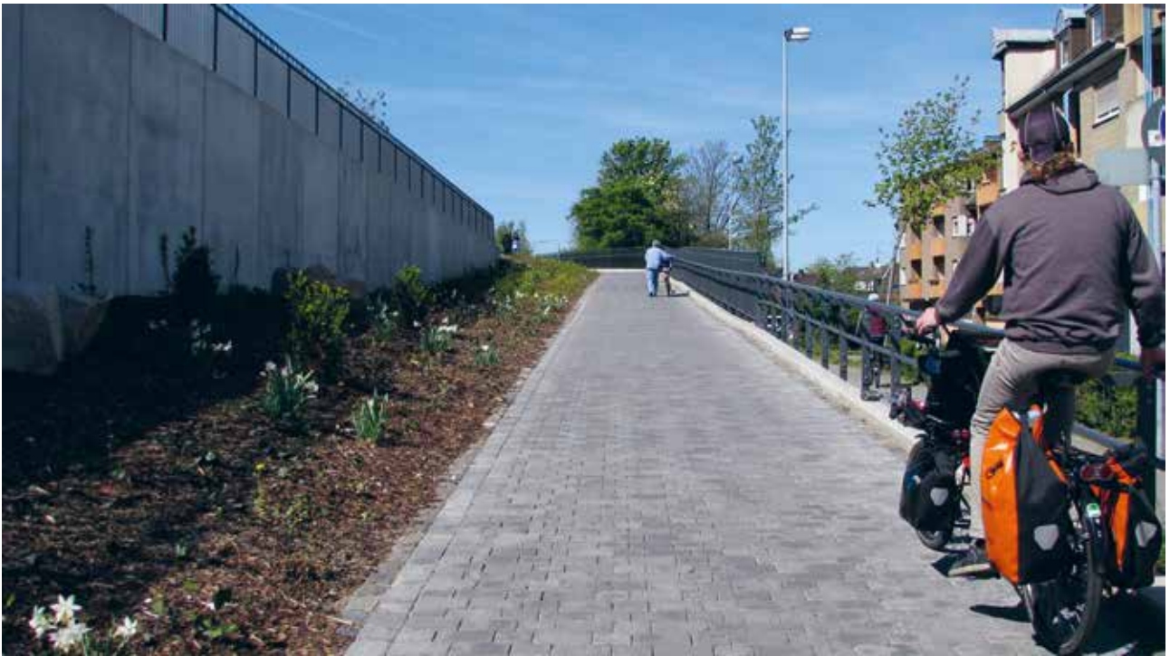
Abbildung 32: Beispiel für die Anbindung einer RSV mittels einer Rampe (Bild 1: Ursula von Katte, LS NRW)
