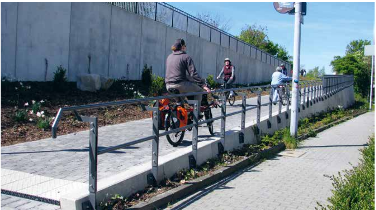
Abbildung 33: Beispiel für die Anbindung einer RSV mittels einer Rampe (Bild 2: Ursula von Katte, LS NRW)
