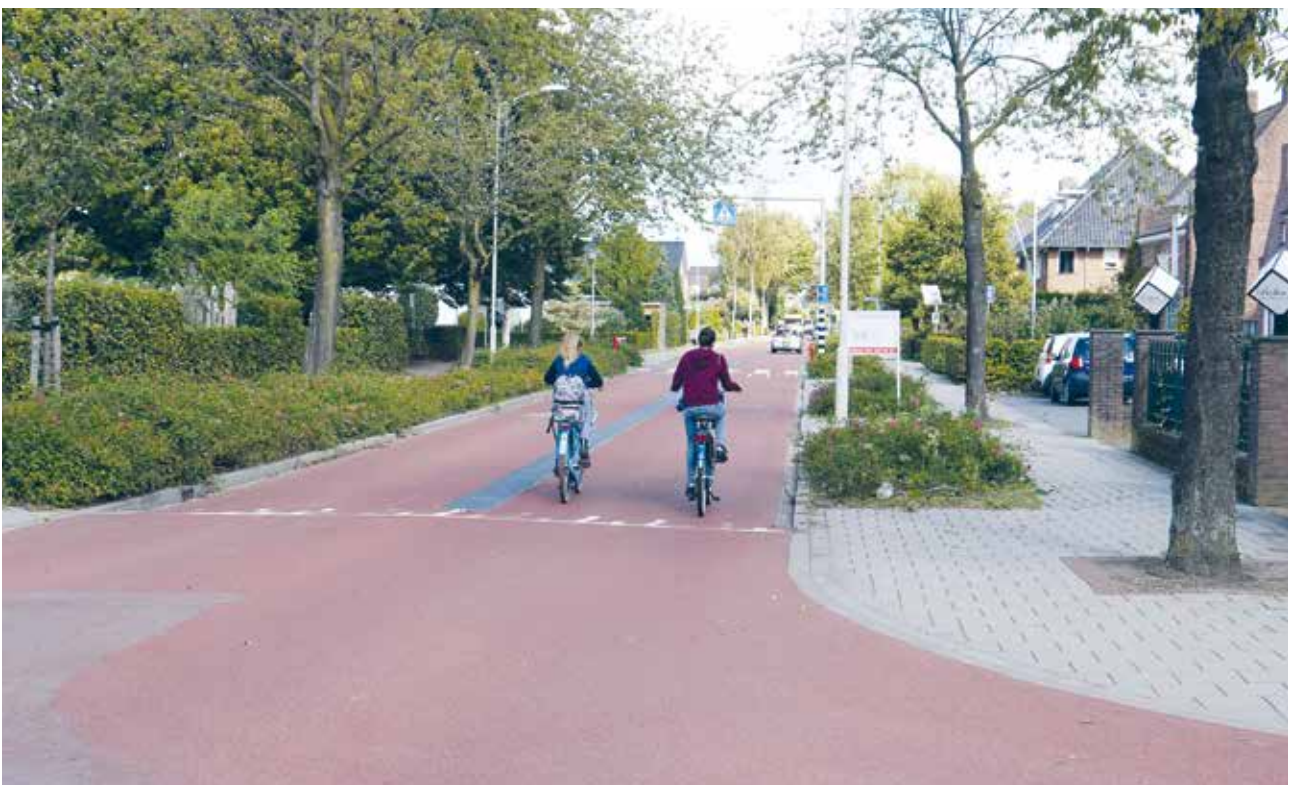
Abbildung 7: Fahrradstraße in Nijmegen, NL (Bild: Planerbüro Südstadt)
