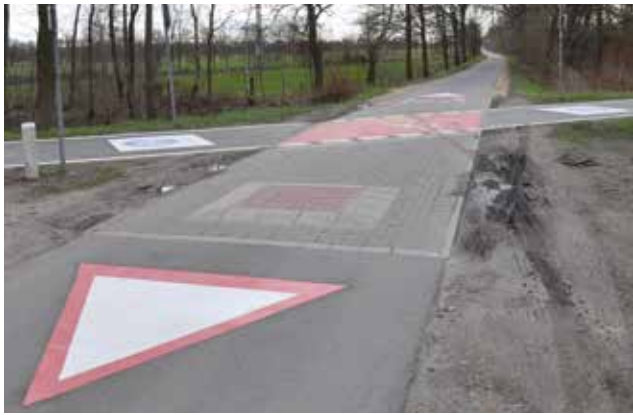
Austausch Pflasterbelag durch Asphaltdecke auf Veloroute und Austausch Asphaltdecke durch Pflasterbelag aufzuführenden Wegen, Einbau von Berliner Kissen, Markierungen und Beschilderung (noch nicht vollständig umgesetzt)
