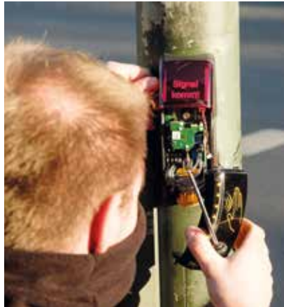
An der Ampelanlage Bender-/Dreher-/Neunzigstraße in Gerresheim wurde der berührungslos arbeitende Taster montiert.
