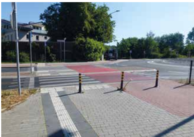
Kreisverkehrsplatz an der L 223 in Herzogenrath mit farblicher Markierung und Anrampung der Fuß- und Radverkehrsfurten. Foto: Straßen.NRW
