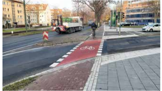
Der barrierefreie Ausbau der Querung Redinghovenstraße mit Absenkung der Bordsteine sorgt für mehr Komfort für den Radverkehr. Foto: Amt für Verkehrsmanagement Düsseldorf
