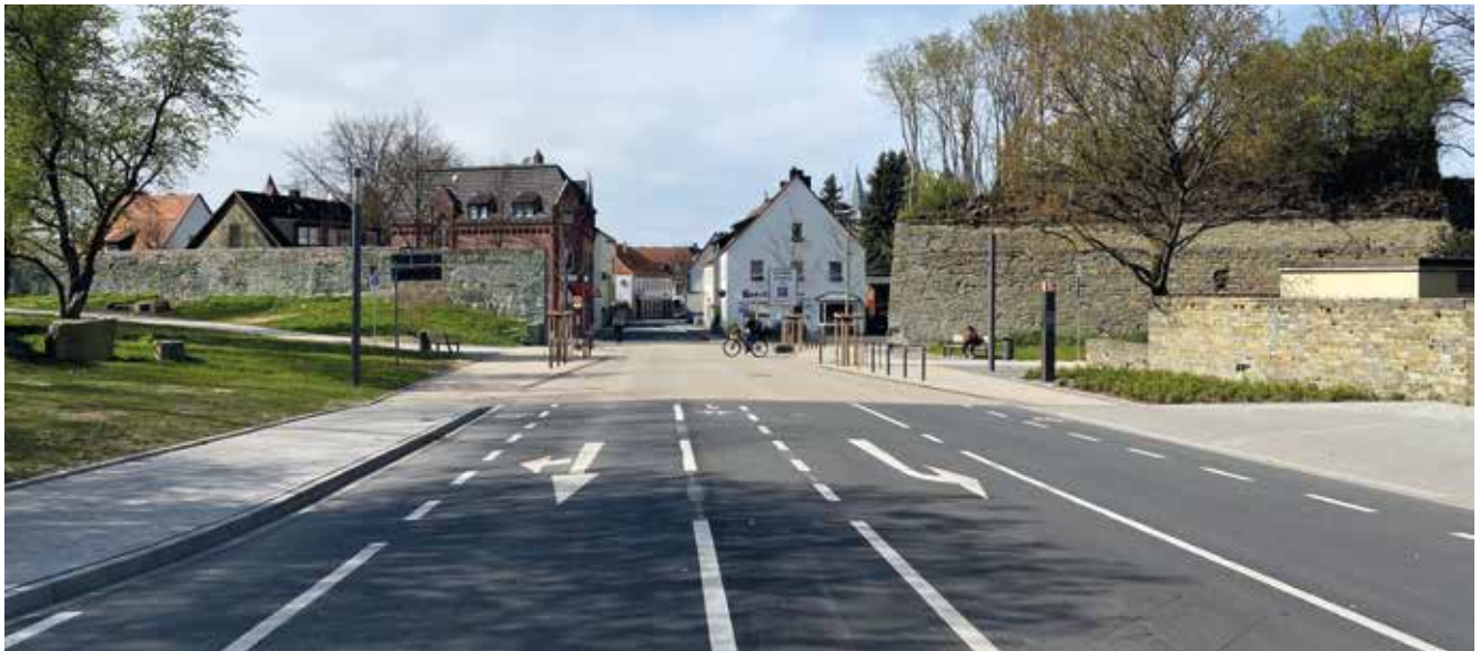
Das Grandwegertor in Soest nach dem Ausbau. Foto: Stadt Soest
