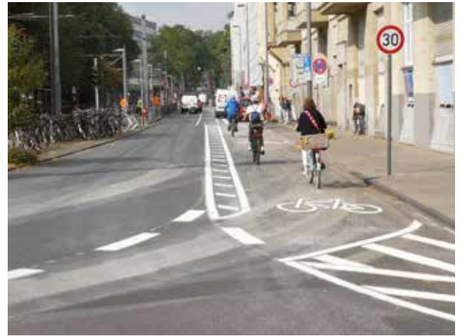
Der Uberring – nach Durchführung der Maßnahme
