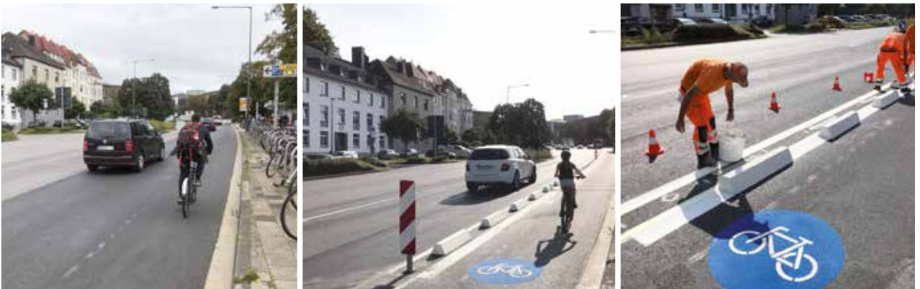
Pontwall Blick Richtung Königshügel (vorher und nachher), rechts: Arbeiten am baulich getrennten Radfahrstreifen. Fotos: Stadt Aachen
