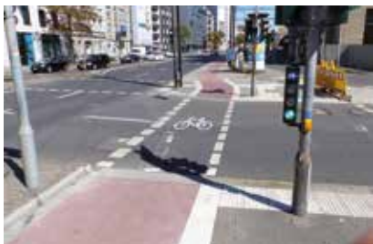
Die Ampeln an den Einmündungen auf dem gesamten Teilstück wurden umgebaut und mit Radverkehrsampelel ausgestattet.
