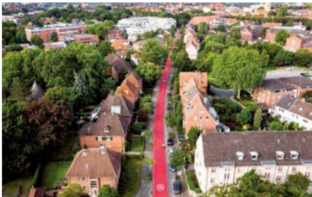
Drohnenaufnahme der fertiggestellten Fahrradstraße Goldstraße. Foto: Patrick Schulte
