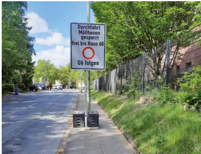
Wenn Baustellenausschilderungen für den Fahrzeugverkehr auf dem Gehweg stehen, sollten sie Fußgänger nicht behindern.
